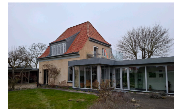
Ahornvej 15, opf. 1917, tilbygning 1967
